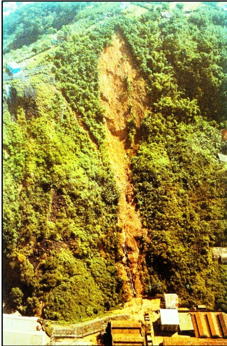
Escorregamento Translacional Raso (ou Planar) típico. Local: Morros de Santos e São Vicente. Notar a proximidade da “raiz” da crista do espigão e a pouca profundidade dos solos superficiais mobilizados. (Foto Arquivo IPT).
