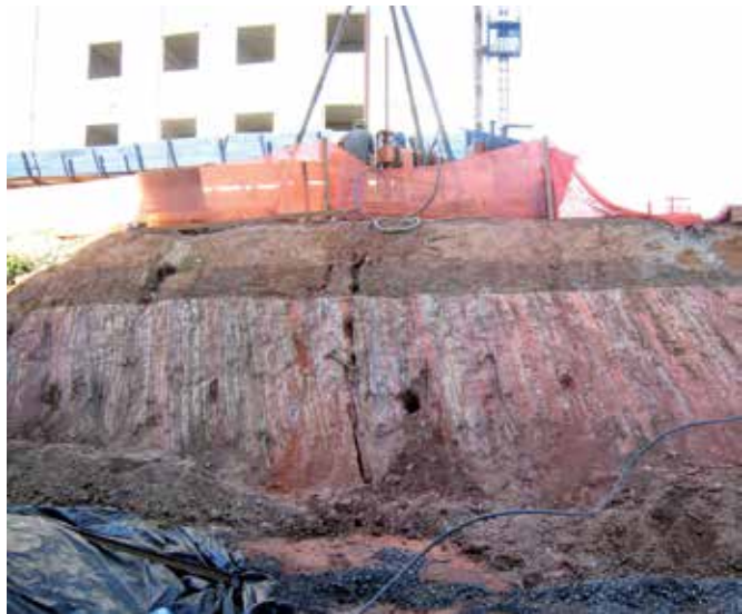
Figura 6 – Notar a orientação praticamente vertical dos diversos estratos xistosos metamorfizados. A rocha calcária são encontra-se em média de 30 – 80 metros de profundidade a partir desse nível
