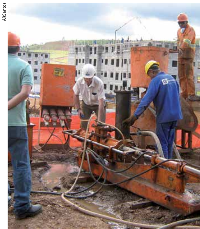
Figura 19 – Bomba pneumática utilizada para a injeção de calda de cimento com misturador acoplado
