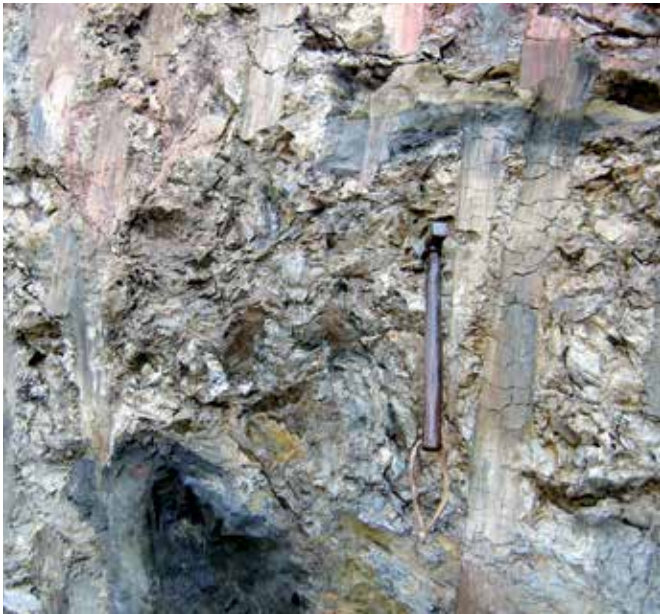
Figura 10 – Detalhe da zona de interface solo/rocha brechoide argilosa e cárstica
