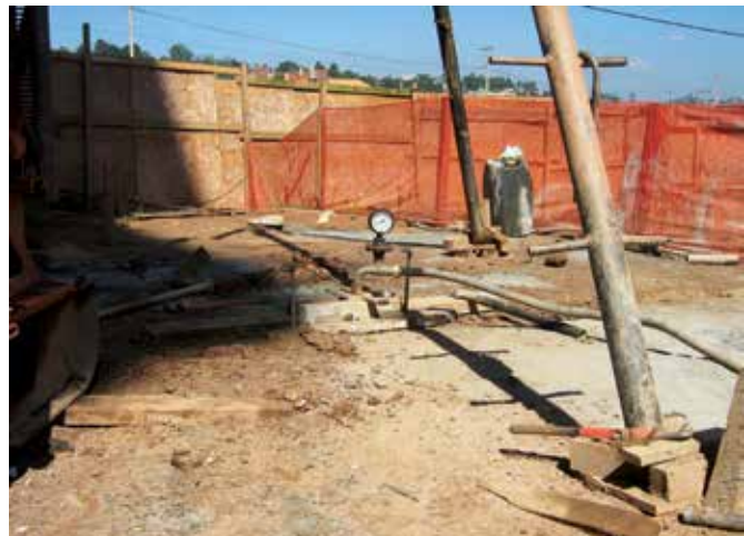
Figura 20 – Ponto sendo injetado com controle de manômetro
