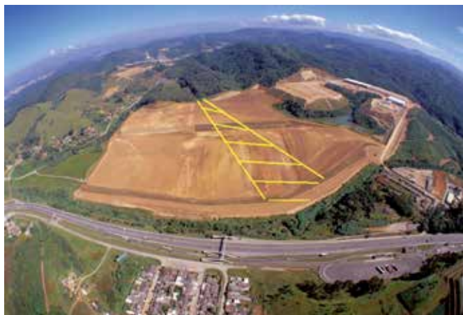
Figura 14 – Empreendimento imobiliário em que a prospecção geológica detectou faixa de concentração de vazios cársticos (linhas amarelas), coincidente com o alinhamento cárstico Lavrinhas
