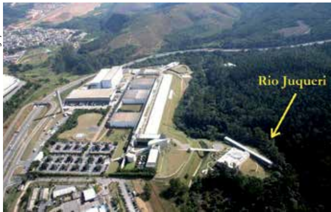
Figura 2 – Moderna fábrica da Natura contígua à Via Anhanguera, bairro de Polvilho em Cajamar – SP, afetada por fenômenos cársticos. Notar a associação com o vale do Rio Juqueri
