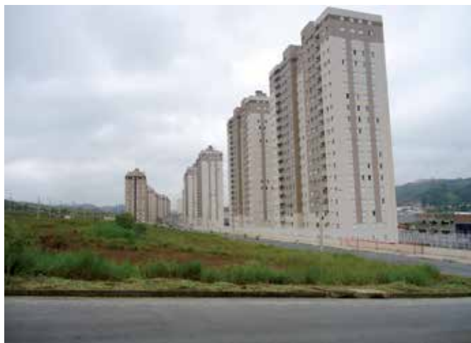
Figura 13 – Grande empreendimento imobiliário que teve uma segunda fase avançando sobre a faixa do vale aí presente, coincidente com o alinhamento cárstico Natura, apresentado grande concentração de vazios na interface solo/rocha, o que veio a demandar extensivo tratamento geotécnico por injeções de calda de cimento e adoção de estacas hélice contínuas como sistema de fundação
