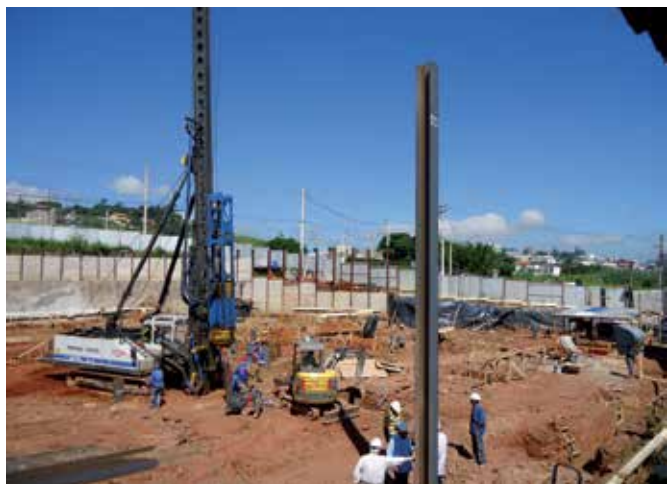
Figura 16 – Empreendimento imobiliário ocupando gleba com concentração de vazios cársticos. As condições geológicas levaram à opção por estacas metálicas cravadas e tratamento dos vazios cársticos com injeção de calda de cimento
