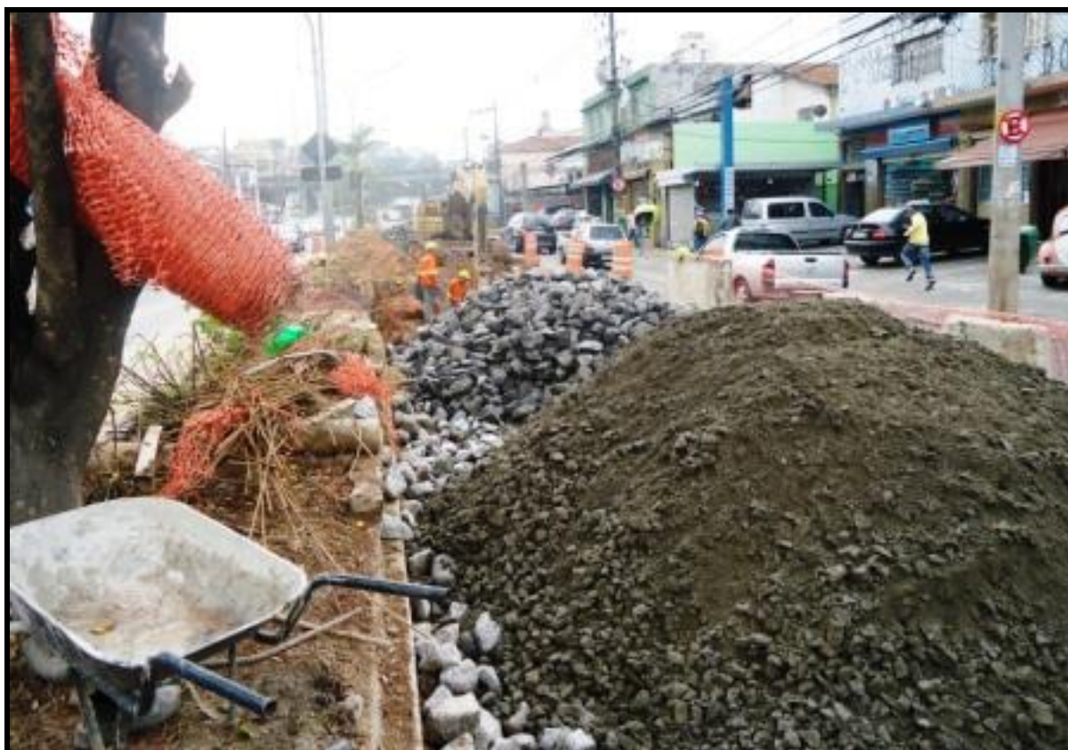
Execução de berço de galeria de drenagem com rachão selecionado e brita graduada, serviço que poderia ser perfeitamente realizado com a utilização de entulho de construção civil em estado bruto ou semi-bruto, com grande economia para a administração pública e enorme benefício para a sociedade. São Paulo, Capital. Foto ARSantos
