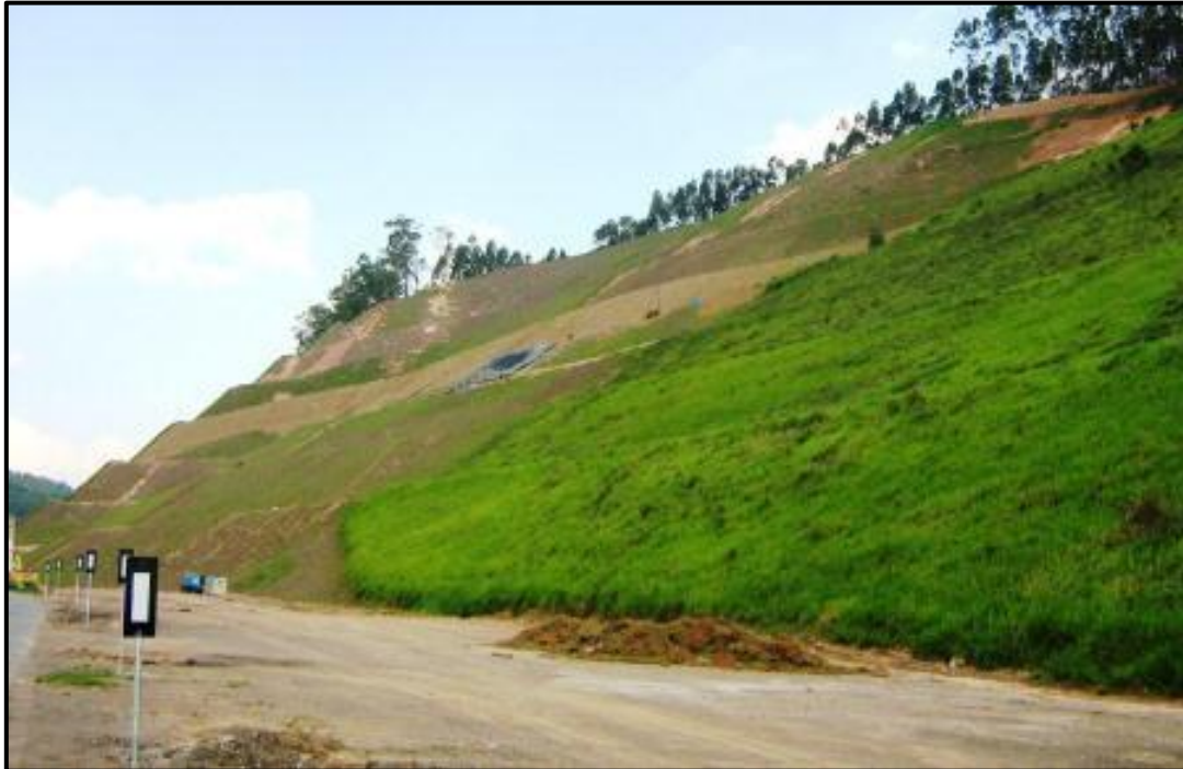
Corte na Rodovia Castelo Branco – SP. Foto ARSantos
