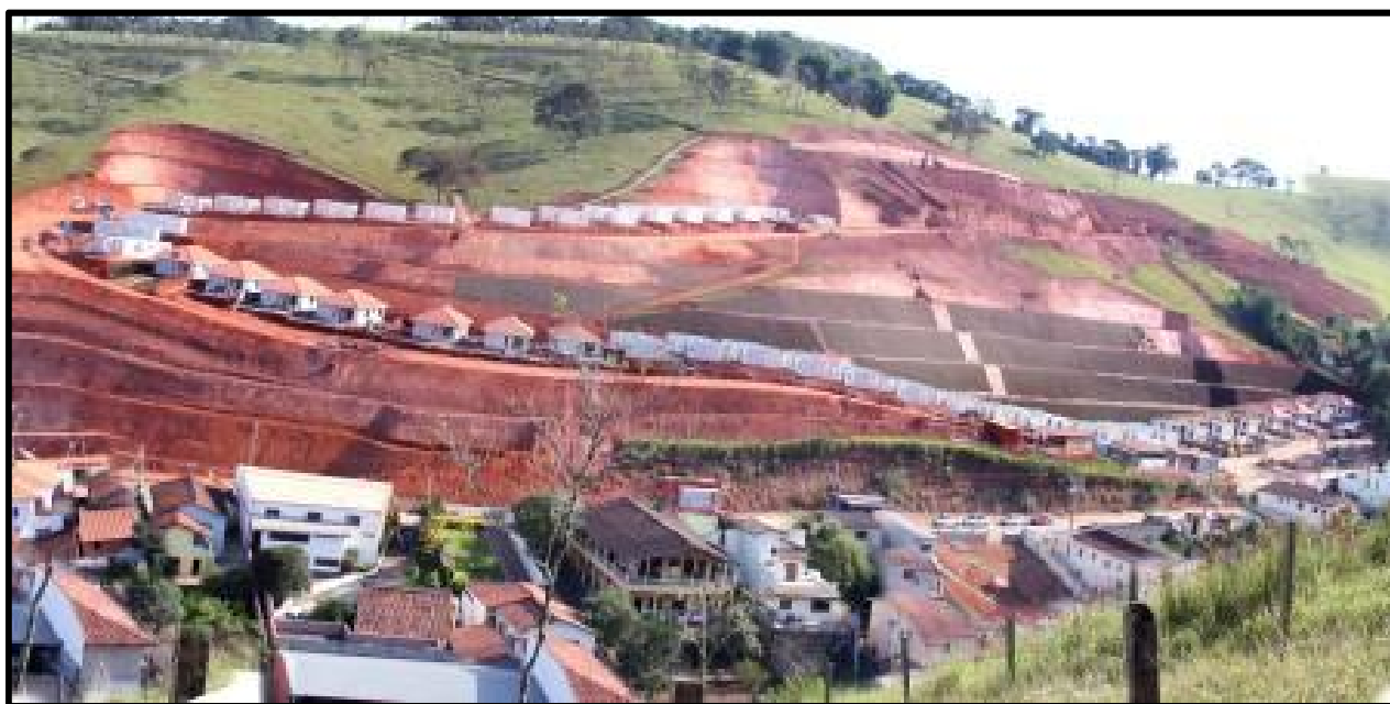
Exemplo de adoção de concepção (produção de patamares planos via operação de terraplenagem) totalmente inadequada a terrenos de média e alta declividade
