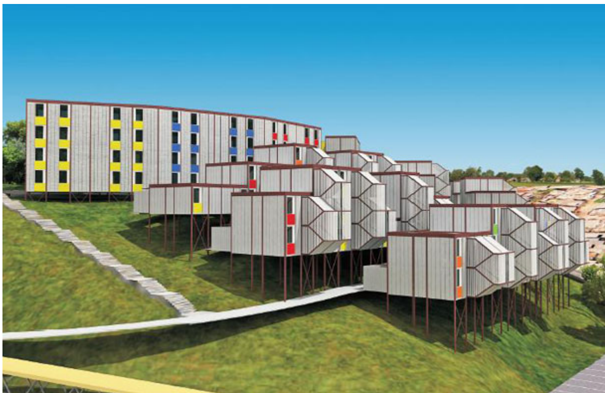
Projeto desenvolvido pelo arquiteto João Filgueiras Lima (Lelé) plenamente adequado (lajes sobre pilotis) a terrenos de média e alta declividade
