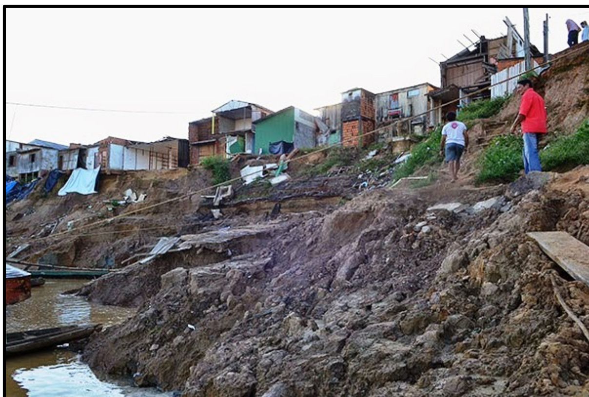
Fenômeno de “terras caídas” em margens de rios da Bacia Amazônica
