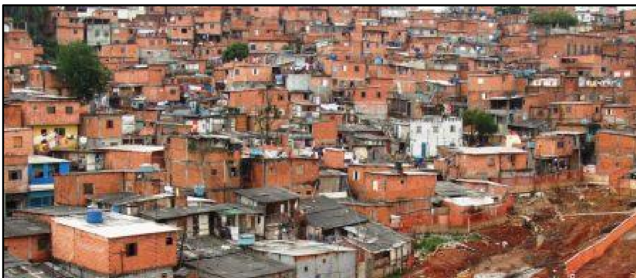
Periferias de grandes cidades brasileiras: oceanos de autoconstruções em bloco/laje. A própria população mais pobre criando e elegendo a tecnologia que lhe torna possível ter sua casa própria. (Foto ARSantos)
