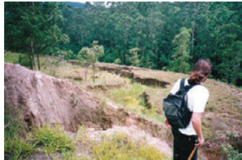
Aterro do Loteamento Continental 3, ocupando parte do antigo talvegue do córrego, sendo lavrado erosivamente por inúmeras ravinas. (Foto do Autor)
