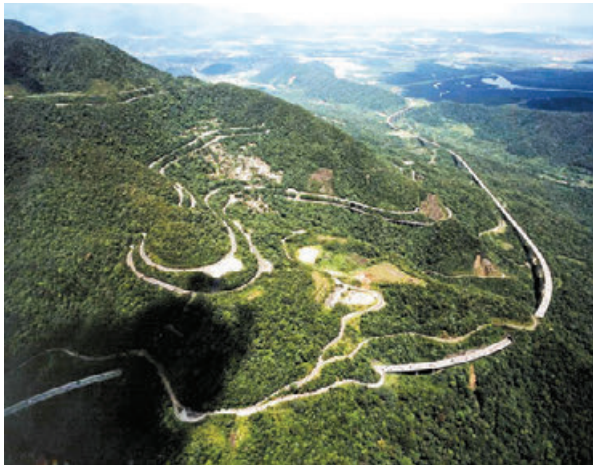
Evolução da tecnologia viária de transposição da Serra do Mar, em função do melhor conhecimento de sua Dinâmica Externa. Acima, a Rodovia Anchieta serpenteia utilizando-se especialmente de cortes na encosta; abaixo, a Rodovia Imigrantes, mais atual, desenvolve-se basicamente por túneis e viadutos, evitando ao máximo interferir nas encostas. Serra do Mar (SP). (Foto Ecovias)
