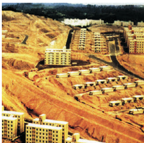
Figura 3 – Conjunto Habitacional Santa Etelvina na capital paulista sendo totalmente erodido. A falta de cuidados com a erosão urbana é trágica para a Região Metropolitana de São Paulo, estando intimamente associada a vários tipos de enchentes. (Foto IPT)
