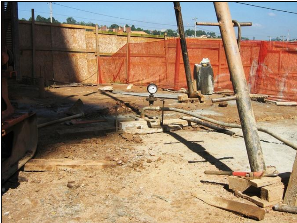
Fig 20 - Ponto sendo injetado com controle de manômetro. Foto ARSantos.
