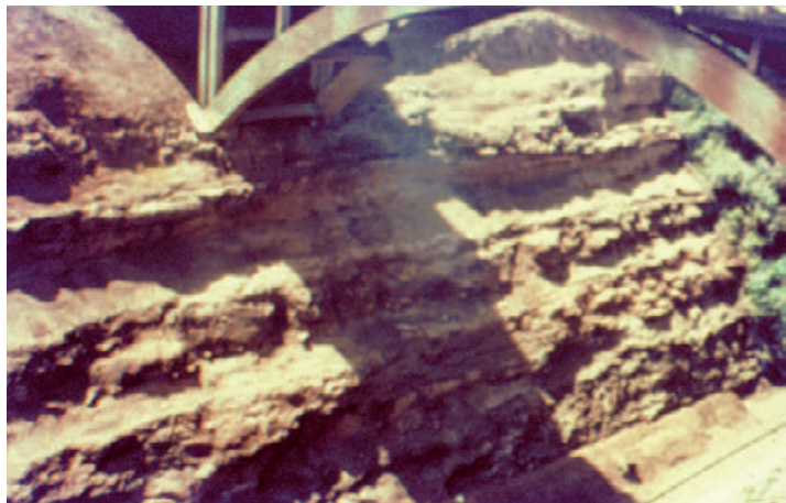
Figura 2 – Limpeza e regularização do talude para aplicação do tratamento. (Foto IPT)
