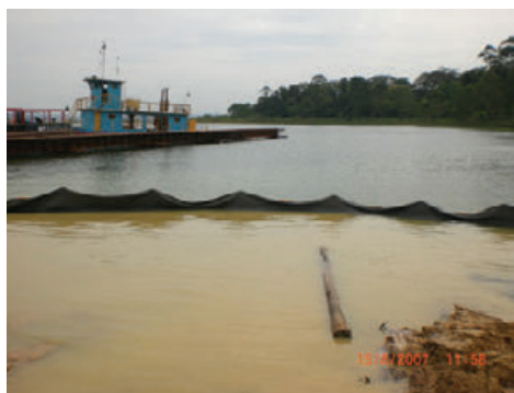
Figura 7 – Detalhe da contenção na turbidez da água com a manta geotêxtil. (Fonte: Fernando Kertzman)
