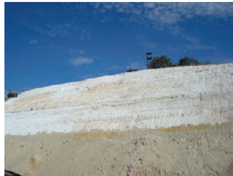
Grande talude protegido concomitantemente com o avanço da terraplenagem. (Foto do Autor)
