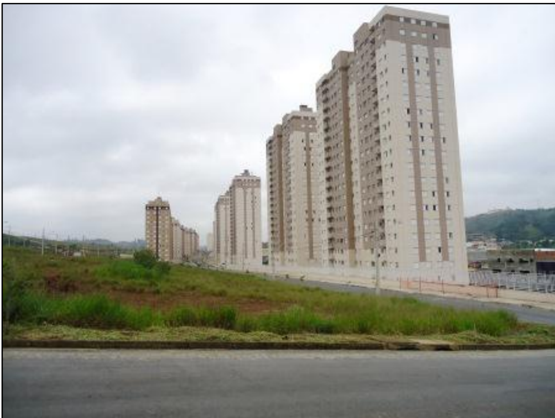
Fig 13 - Grande empreendimento imobiliário que teve uma segunda fase avançando sobre a faixa do vale aí presente, coincidente com o alinhamento cárstico Polvilho - Natura, apresentou grande concentração de vazios na interface solo/rocha, o que veio a demandar extensivo tratamento geotécnico por injeções de calda de cimento e adoção de estacas hélice contínuas como sistema de fundação. Foto ARSantos.
