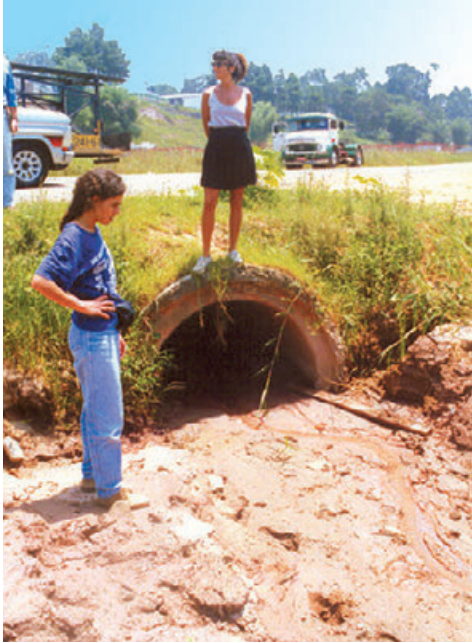
Figura 5 – Pequenas drenagens são as que mais sofrem com o assoreamento. (Foto IPT)
