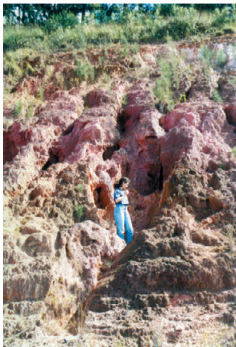
Figura 2 (A e B) – Taludes contíguos, em solo de alteração de rochas cristalinas e em sedimentos terciários e solos superficiais laterizados, evidenciando a extrema maior suscetibilidade à erosão do solo de alteração de rochas cristalinas. (Fotos do Autor)
