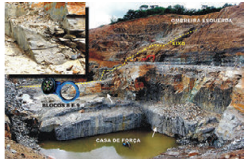
Figura 3 – Situação das escavações no final de 2007, quando afloraram as descontinuidades sub-horizontais que condicionaram a estabilidade ao deslizamento ao longo dessas feições. As setas brancas indicam as feições. A lupa indica a posição ampliada no canto esquerdo superior, mostrando a descontinuidade que deu origem à situação descrita. (Fonte: Ricardo Antônio Abrahão)
