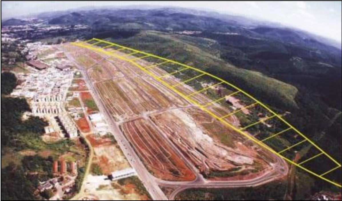
Fig 12 - Extensa faixa de concentração de vazios cársticos expressa geomorfologicamente pela zona de fundo de vale (alinhamento 3 - Polvilho - Natura) ocupada por grande empreendimento imobiliário. Desenho ARSantos sobre imagem aérea.
