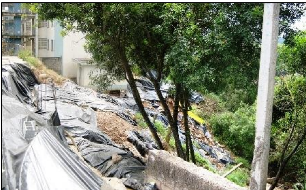
Conjunto Residencial da CDHU construído em cabeceira de grota contribuiu com a reativação de sua dinâmica evolutiva. Franco da Rocha SP. Foto do autor.
