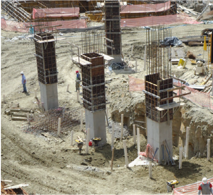
Figura 6 – Tubos guias de PVC aparentes junto às sapatas periféricas. (Foto do Autor)
