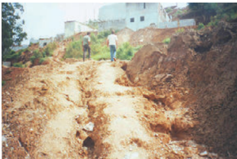
Arruamentos precários já totalmente comprometidos pela erosão. (Fotos do Autor)
