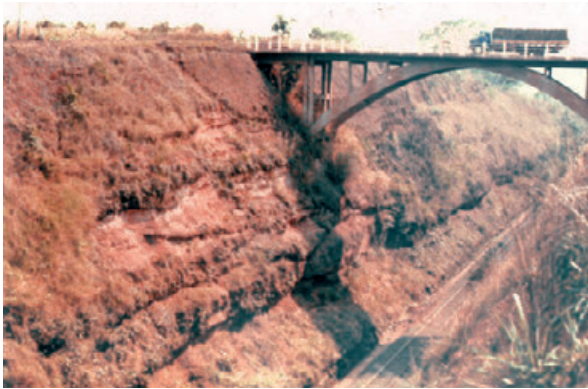
Figura 1 – Talude mostrando o descalçamento de bancos de arenito pela desagregação superficial (“empastilhamento”) de lentes silto-argilosas sotopostas. (Foto do Autor)
