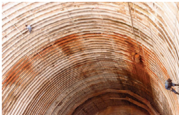
Trabalho arriscado. Instalação de medidores de convergência nos anéis do poço distribuidor da Estação de Tratamento de Esgoto, Barueri-RMSP, escavado em sedimentos quaternários e terciários. (Foto IPT)
