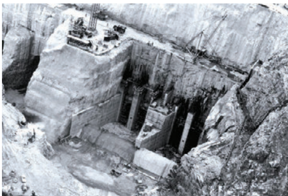
Usina Hidrelétrica de Paulo Afonso IV. Escavações para a instalação da Casa de Força. Necessidade de utilização de fogo controlado e técnicas de estabilização e impermeabilização de maciços rochosos. (Foto IPT)
