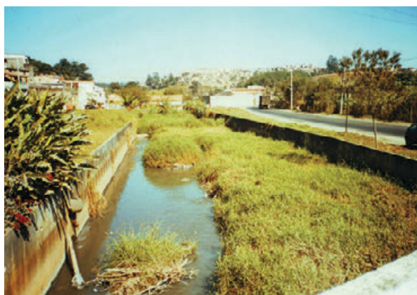
Figura 9 – Tomada d'água do "piscinão" do córrego Saracantã, em São Bernardo (SP), totalmente assoreado com pouquíssimo tempo de operação. (Foto do Autor)
