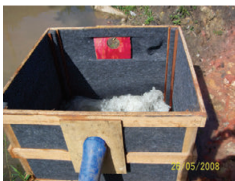
Figura 9 – Funcionamento da caixa de filtração instalada em local de difícil acesso de maquinário da obra. (Fonte: Fernando Kertzman)
