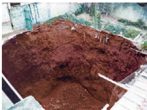
Figura 3 – “Afundamento” iniciado, por sorte, no quintal de uma residência (12/8/86). (Foto IPT)
