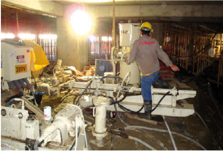
Figura 8 - Bomba hidráulica e equipamentos misturadores de calda em operação no local. (Foto do Autor)
