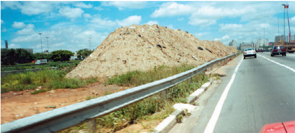
Figura 6 – Material de desassoreamento do Rio Tietê empilhado às suas margens para posterior remoção para bota-foras. (Foto do Autor)
