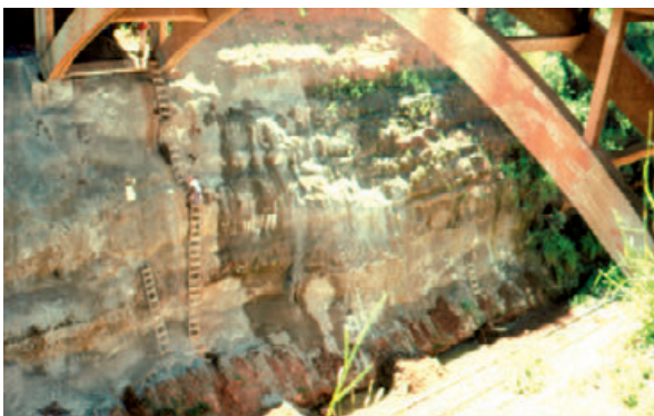
Figura 3 – Aspecto do talude após a aplicação do concreto projetado sobre tela metálica pinçada. (Foto IPT)
