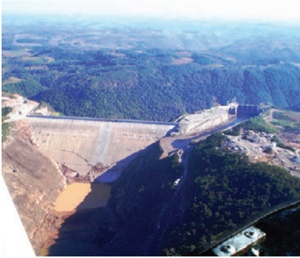
Barragem de Campos Novos (SC/RS), vista de montante para jusante, logo após seu brusco e total esvaziamento. O acidente ocorreu em função de violenta fuga de água propiciada por falhas de consolidação e vedação nos túneis de desvio. (Foto Savingicelan)
