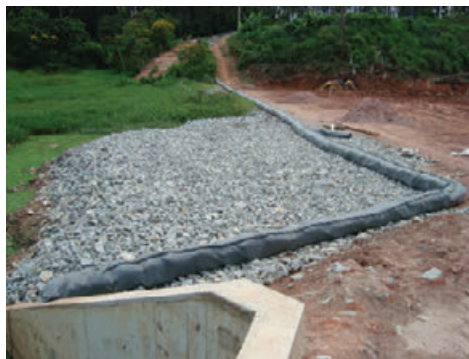
Figura 5 – Linha de sacaria envelopada com manta geotêxtil. A utilização desses dois tipos de contenção tem se mostrado bastante favorável tanto na contenção dos sedimentos mais grosseiro do solo como também nas partículas mais finas. (Fonte: Fernando Kertzman)
