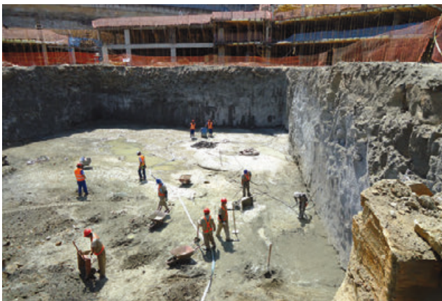
Figura 5 – Serviços de limpeza e tratamento do piso e taludes laterais da escavação das sapatas-radier. (Foto do Autor)
