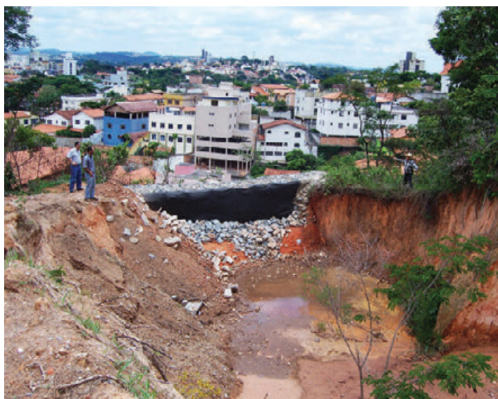
Figura 2 – Detalhe da grande ravina e da implantação de estrutura permeável de contenção como elemento estrutural da recomposição do maciço. (Foto do Autor)
