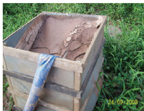
Figura 10 – Interior da caixa de filtração com os sedimentos acumulados ao longo da atividade de bombeamento. (Fonte: Fernando Kertzman)
