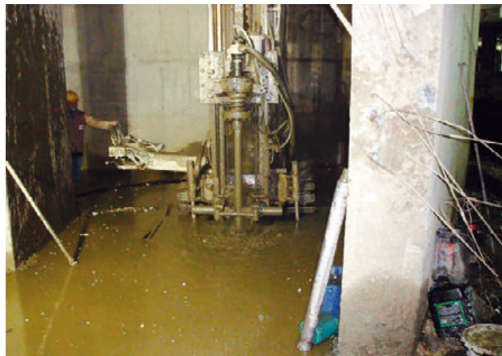
Figura 7 - Perfuratriz em operação sobre a superfície do blocoradier. (Foto do Autor)
