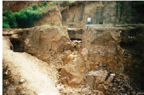
Arruamentos precários já totalmente comprometidos pela erosão. (Fotos do Autor)
