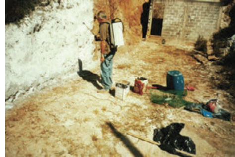
Fazendo a aplicação com pulverizador costal manual. (Foto do Autor)
