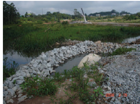
Figura 2 – Leira de rachão implantada na entrada de sistema de drenagem para contenção de sedimentos provenientes da área de escavação. (Fonte: Fernando Kertzman)
